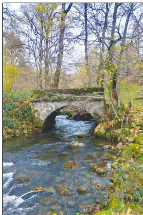
Photo de couverture – Pont sur la Doire ©Mas
