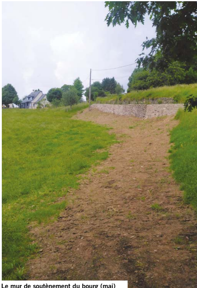
Le mur de soutènement du bourg (mai)
